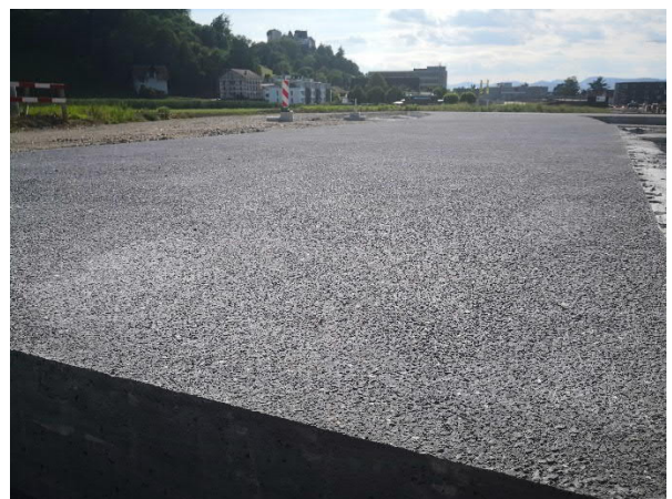
Bild 6: Fertiggestellte Waschbetonoberfläche, Mai 2020
