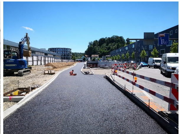
Bild 10: Strassenbau entlang der Rampe Hero, Juni 2020
