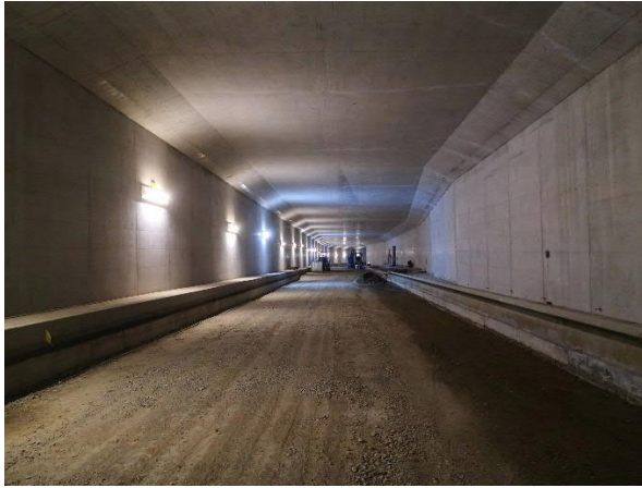
Bild 1: Tunnel im Rohbau, Januar 2020
