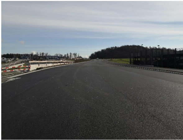
Bild 13: Strassenbau Hendschikerstrasse, November 2020
