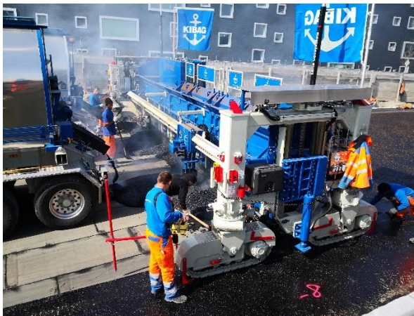
Bild 3: Einbau Gussasphalt auf Tunneldecke mit Fertiger, März 2020
