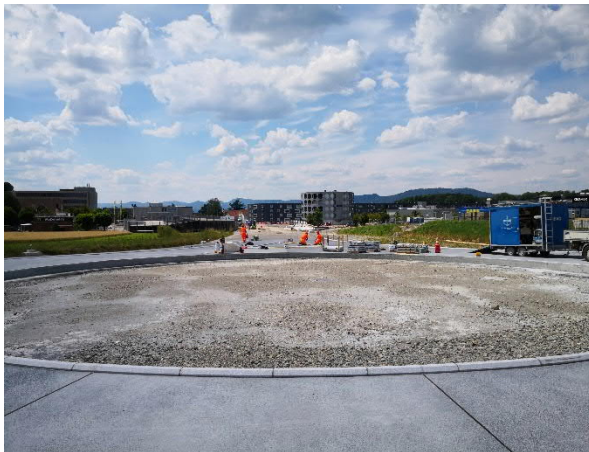
Bild 11: Kleben der Randabschlüsse auf dem Betonkreisel, Juli 2020
