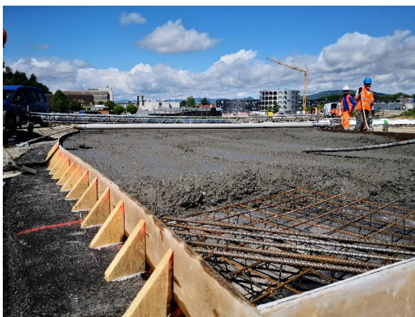
Bild 5: Erste Betonetape Kreisel Horner, Mai 2020
