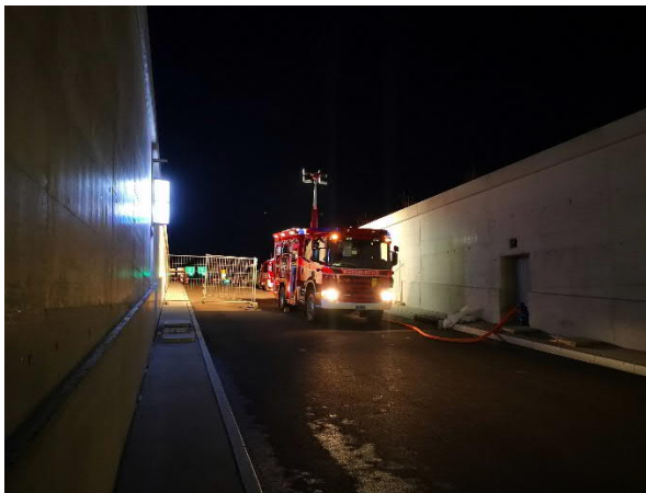
Bild 17: Einspeisung Trockenleitung, Februar 2021
