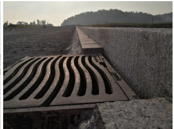
Bild 12: Detail Randabschlüsse und Entwässerung an der Henschikerstrasse AO, September 2020
