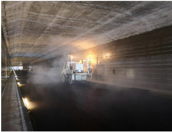
Bild 7: Hydrophobierung der Betonoberflächen, Mai 2020
