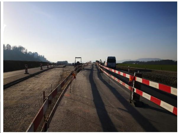
Bild 18: Belagsarbeiten Einbindung Horner, März 2021
