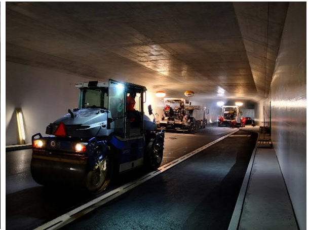
Bild 8: Deckbelagseinbau im Tunnel, Juni 2020
