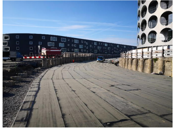
Bild 2: Abgedichtete Tunneldecke im Bereich des Knotens Neuhof, März 2020
